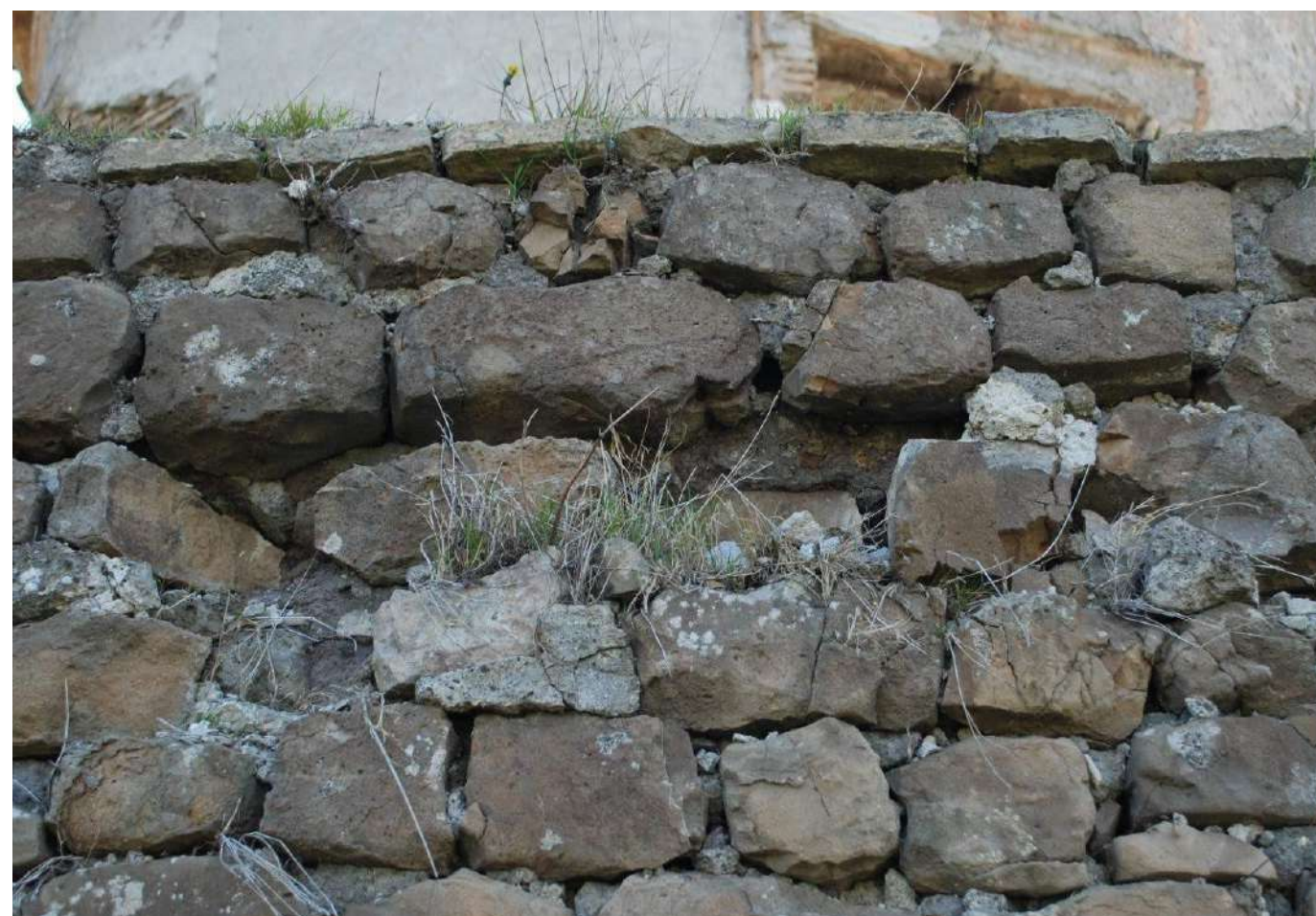
Foto particolare del tamburo dell'antica cisterna
